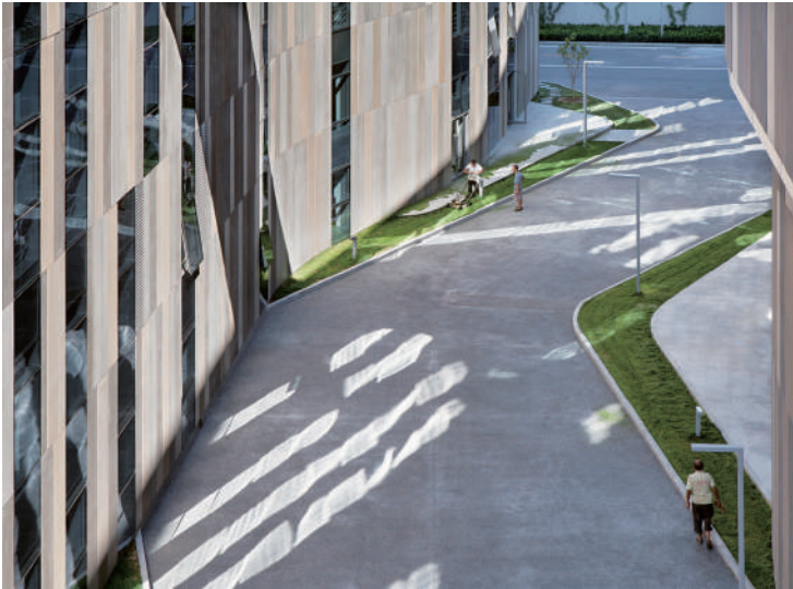
内墙及通高内部景观
