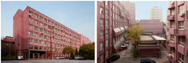
改造前实景：外立面及内院（摄影：董灏）
